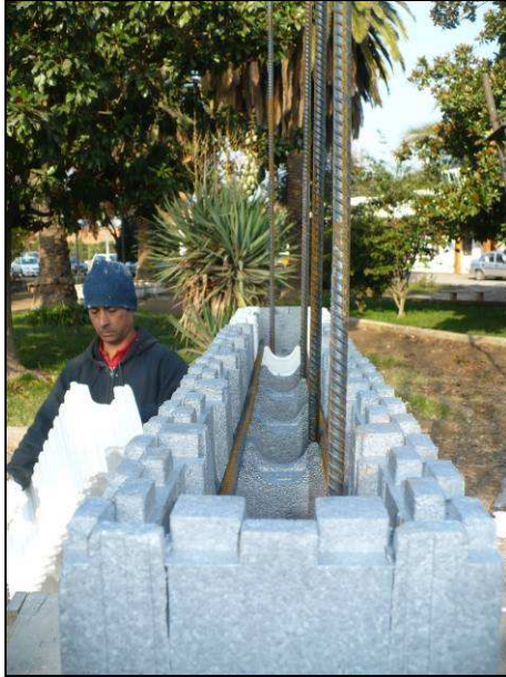
Foto 1. Construcción de probetas, refuerzos verticales y horizontales.
