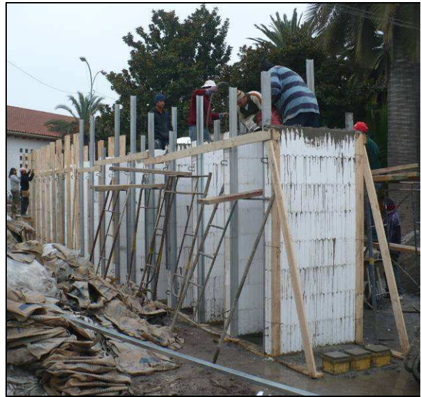
Foto 2. Construcción de probetas, vaciado del hormigón.
