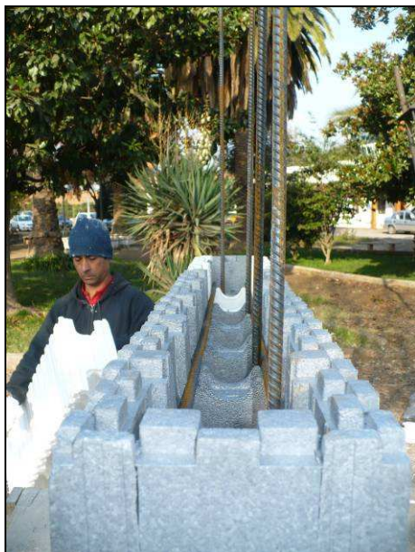
Foto 1. Construcción de probetas, refuerzos verticales y horizontales.
