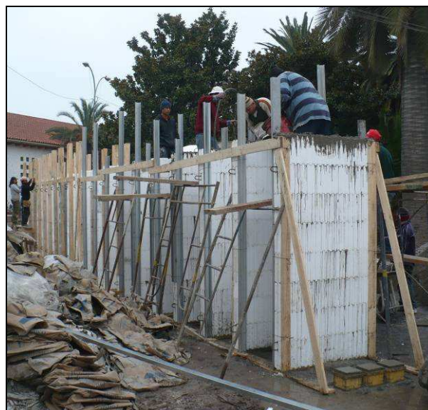
Foto 2. Construcción de probetas, vaciado del hormigón.
