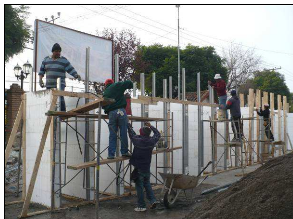
Foto 2. Construcción de probetas, vaciado del hormigón.
