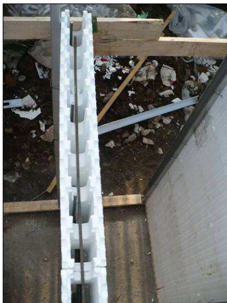
Foto 1. Construcción de probetas, refuerzos verticales y horizontales.
