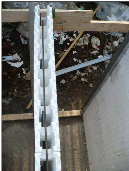
Foto 1. Construcción de probetas, refuerzos verticales y horizontales.
