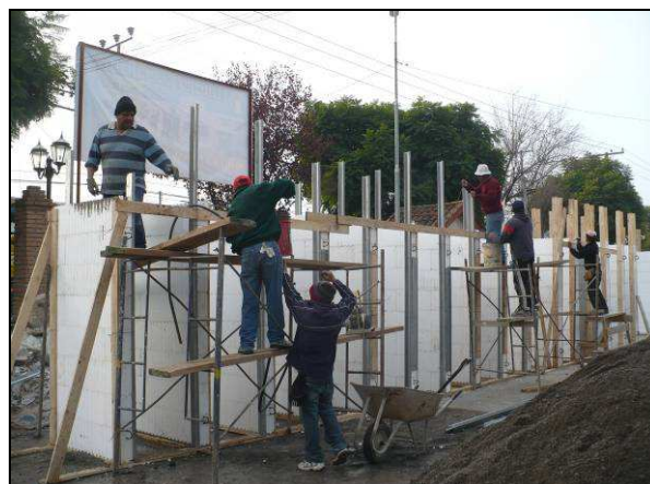
Foto 2. Construcción de probetas, vaciado del hormigón.
