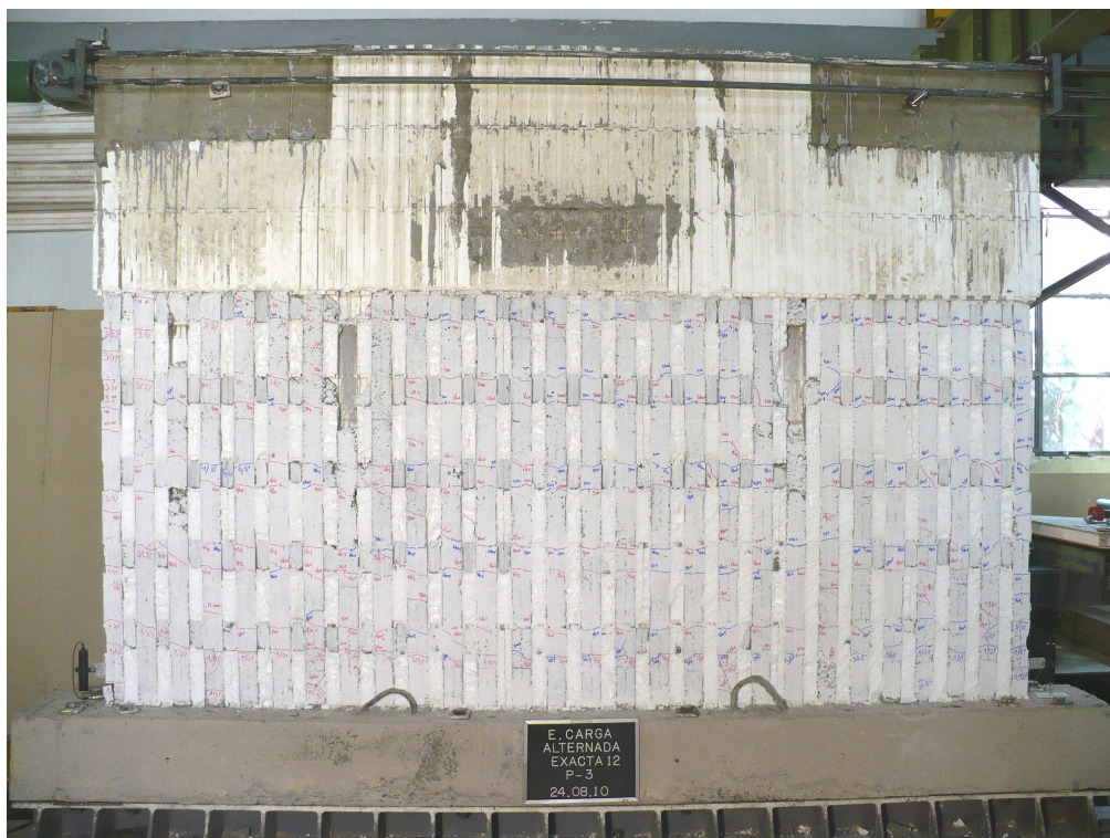
Foto 7. Nivel de daños del muro 3 para el estado límite " Carga máxima ".
