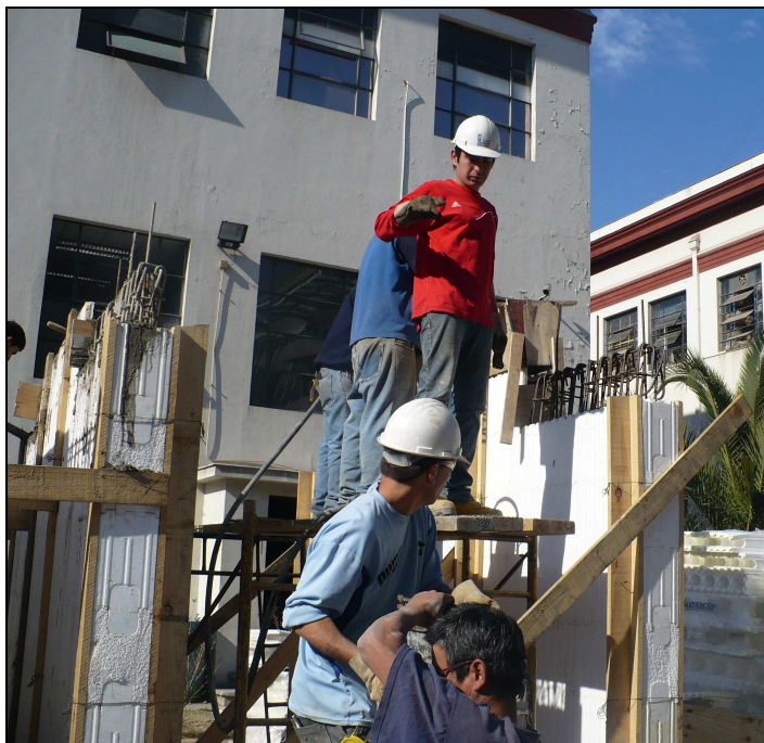
Foto 1. Construcción de probetas, vaciado de hormigón.
